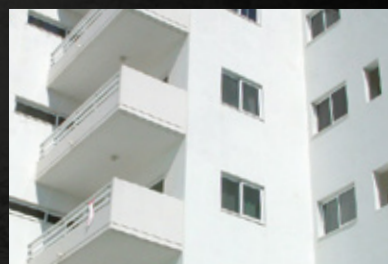
Waterdichting van buitenmuren
